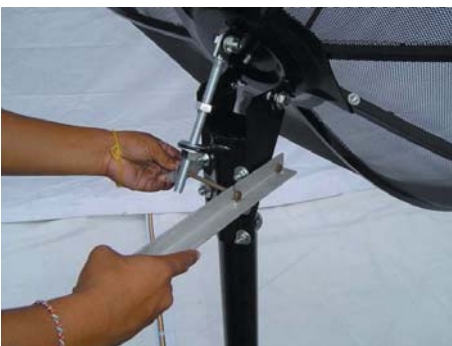
3. ใช้อลูมิเนียมฉากไปจับติดกับคอจาน (ที่ต้องเป็นอลูมิเนียมเพราะไม่มีสนามแม่เหล็กไปรบกวนตัวเข็มทิศ)
